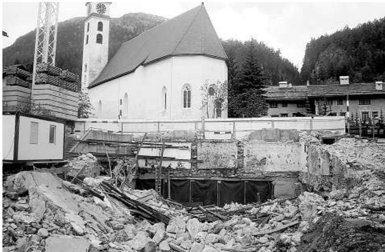
Aufräumarbeiten haben begonnen: Vom 250-jährigen Engadiner Bauernhaus Flugli in Silvaplana sind nur noch Trümmer in einer Baugrube übrig. Bild Werner Bucher
